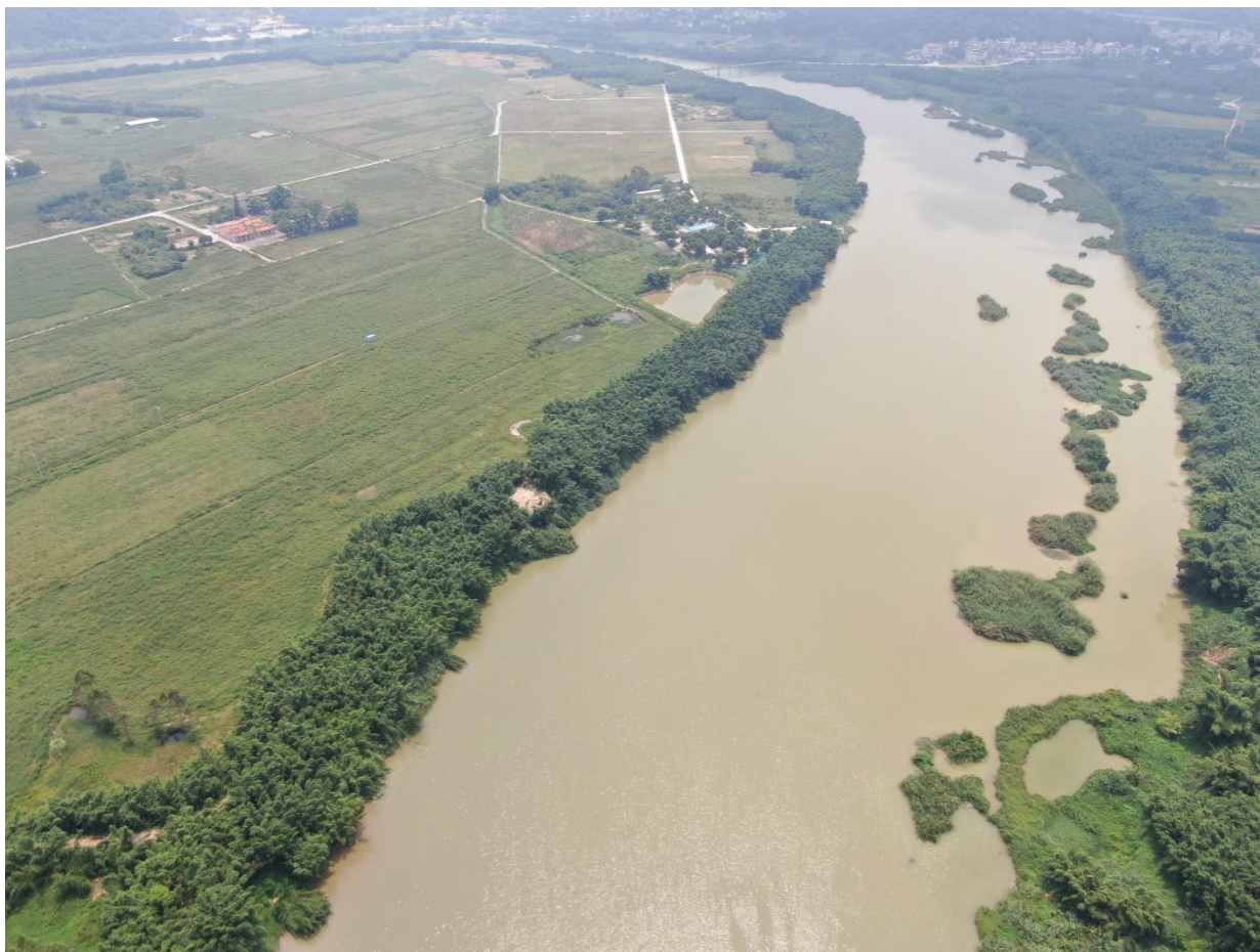
图 6.5-1 堤防加固段现状图
